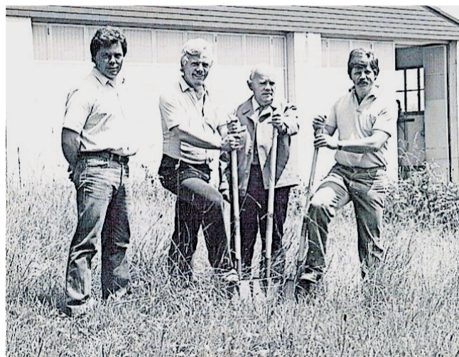
Spatenstich für den Neubau.
